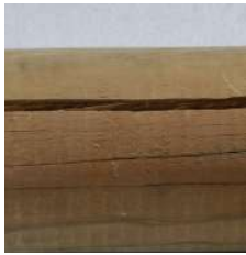
Cracks/Grietas/Fente/Risse/ Crepe/ Barsten/Fendas
