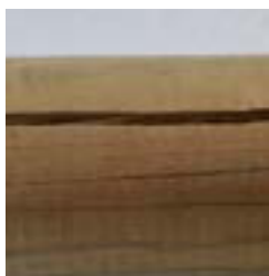
Cracks/Grietas/Fente/Risse/ Crepe/ Barsten/Fendas
