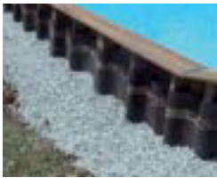
Drainage gravel Grava drenante Gravier drainant Kies zur Entwässerung Ghiaia drenante Steenlag/grind voor drainage Brita drenante
