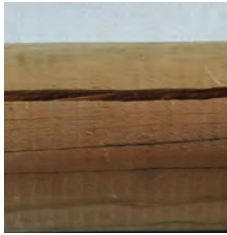
Cracks/Grietas/Fente/Risse/ Crepe/ Barsten/Fendas
