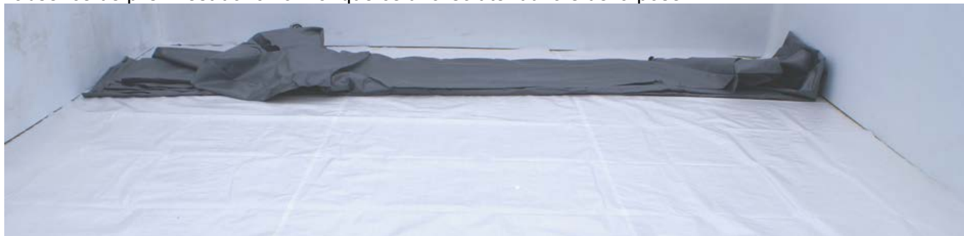
Figure 34 – Dépliage du liner
