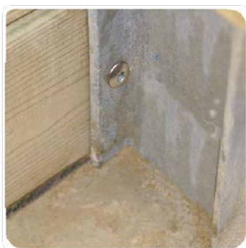
Figure 13 – Verrouillage des madriers sur les jambes de force
