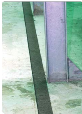
Figure 9 – Mise en place des bandes bitumeuses
