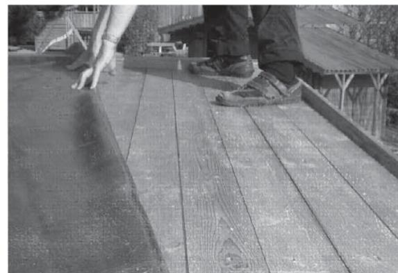
Bij de laatste zigzag-beweging dient de EPDM folie evenwijdig met de dakrand te komen en met de hand goed in de hoek aangeduwd en afgestreken te worden.
